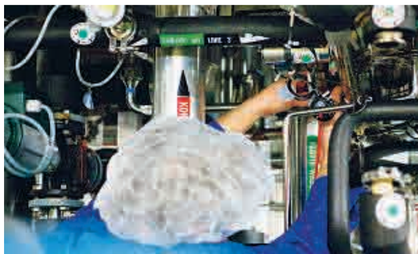
Überblick im komplexen Geflecht der Rohrleitungen: Heinz Kupferschmid's Handgriffe sitzen; Hunderte von Ventilen werden inspiziert und alle Dichtungen ersetzt.
